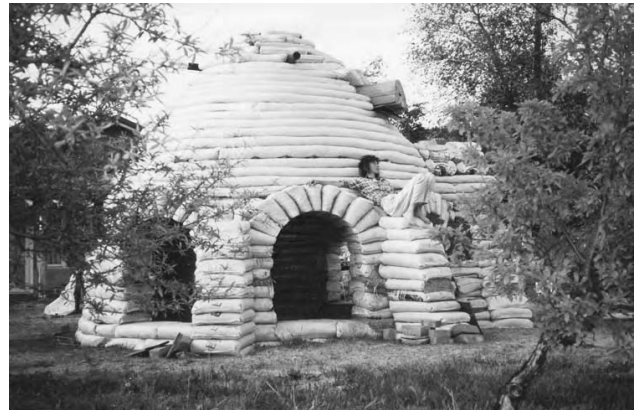
12.33: Lucrarea cu saci terminată la Honey House, după ce am îndepărtat formele.
