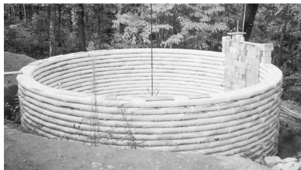
5.7: Forma supremă de contrafortuire este un cerc complet. MARLENE WULF
