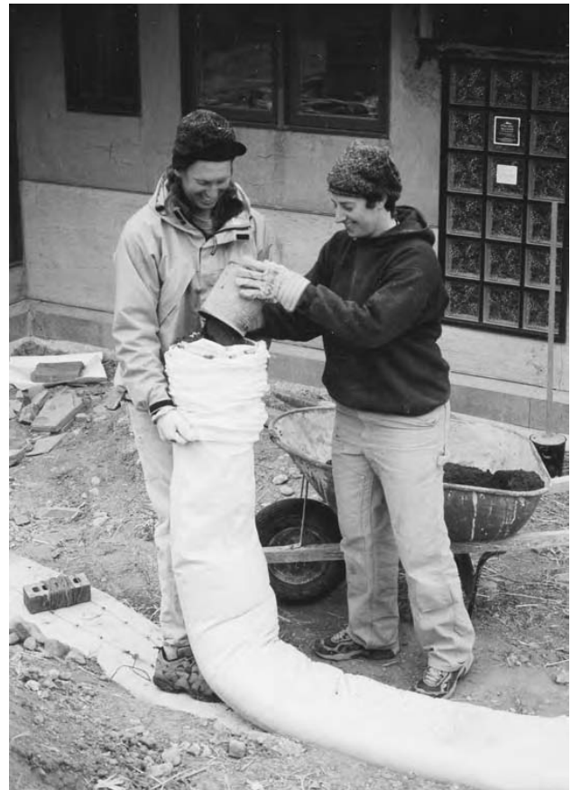
3.24: Un tobogan pentru tuburi se comportă ca un manșon pe care se rulează tubul în lungime, la fel ca o pâlnie pe unde intră pământul.
