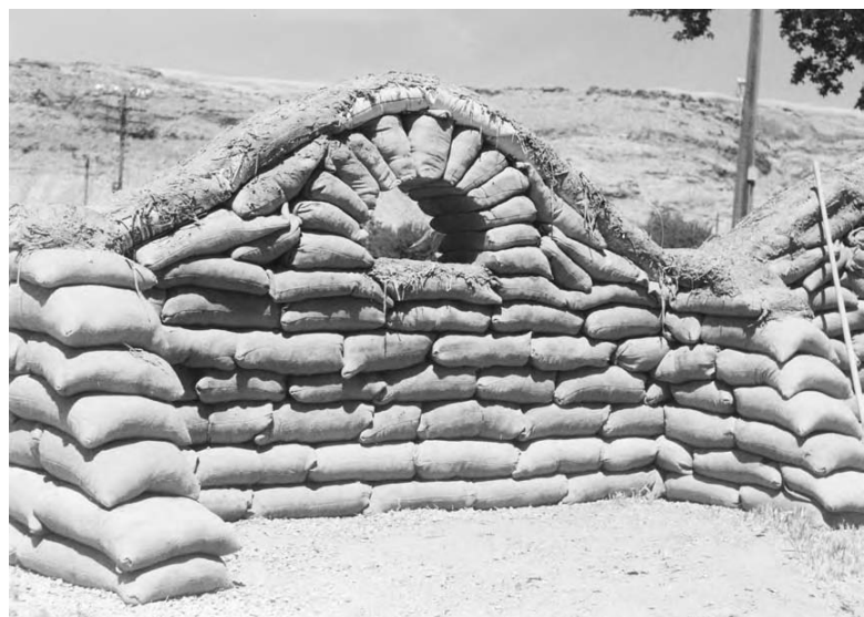
3.4: Lucrarea noastră timpurie cu sacii a semănat cu o grămadă de saci cu nutreț, cu colțurile lor moi ieșind în afară.
