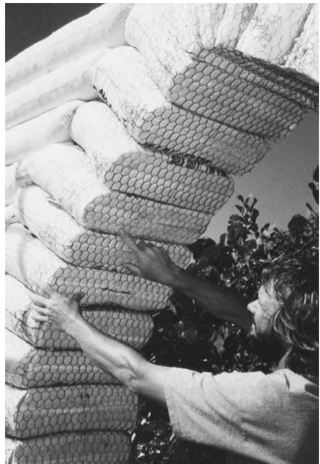
2.34: Suporturile au pe partea de jos a arcelor un substrat ideal pentru aplicarea tencuielii.
