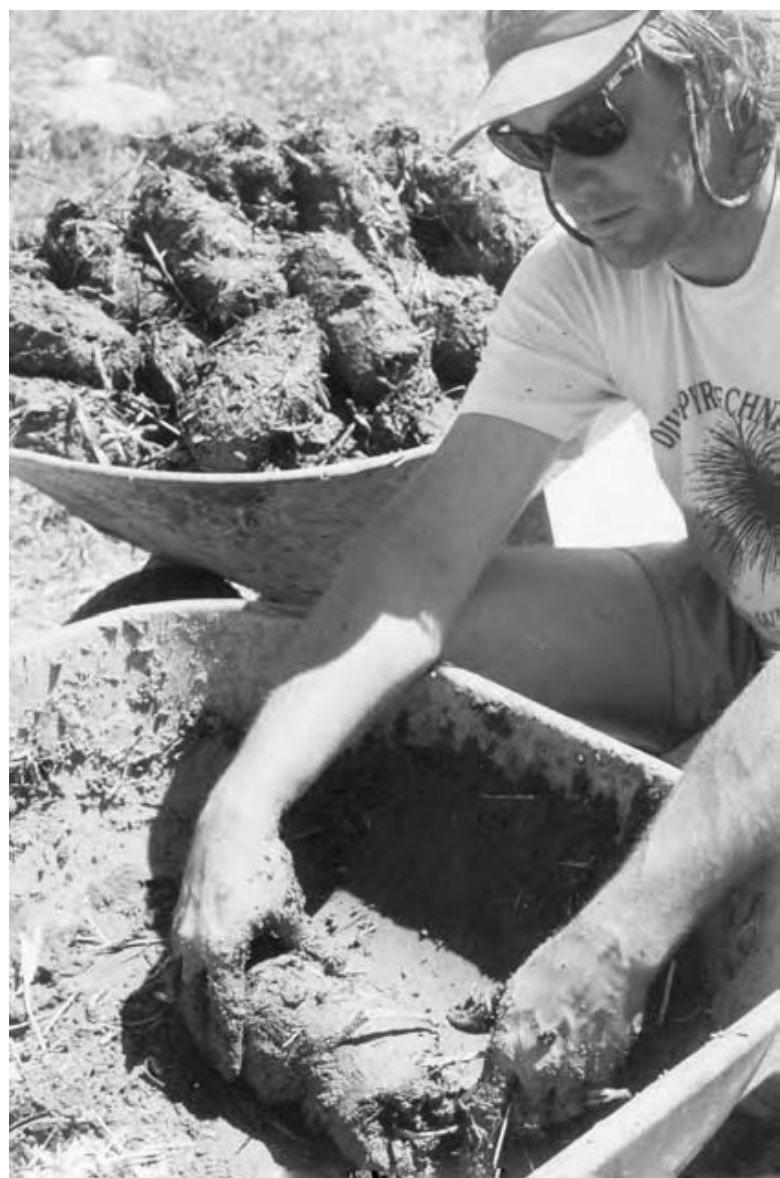
14.12: Pentru a amesteca bucățile de cob mai groase decât mixerul, aruncăm o bucată mare din amestec într-o roabă căptușită cu paie, frământând cobul ca pe pâine, apăsând în centrul bucăților cu degetele mari.
