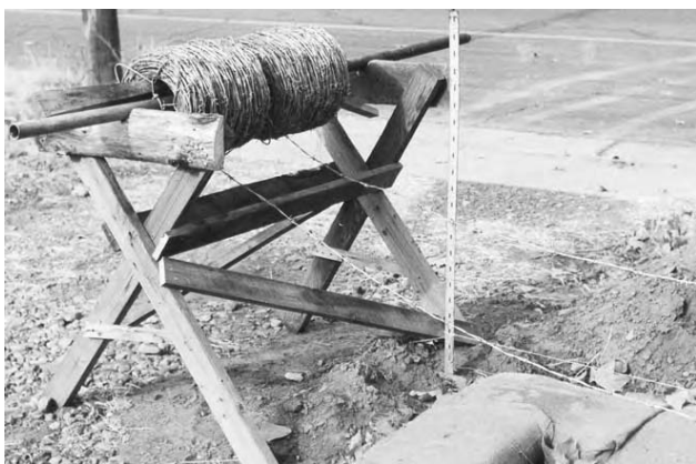
2.19: Capră de lemn transformată într-un suport pentru rola de sârma ghimpată.
