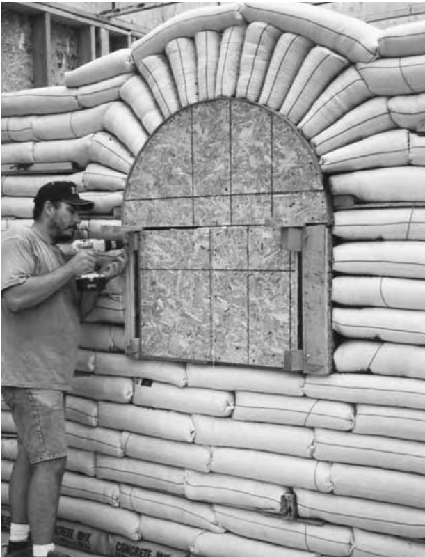
2.26: Cutiile demontabile pot fi adaptate pentru a se potrivi golurilor de mărimi diferite.
