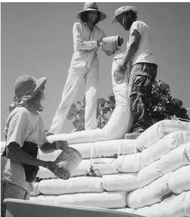
3.29: Persoana care ține toboganul este "stativul pentru sac mișcător", în timp ce "încărcătorul tubului" umple toboganul, iar a treia persoană aduce pământ și îi umple cutii celui ce încarcă.
