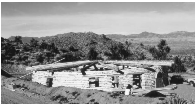
4.18: Casa lui Penny Pennel - tip kiva, bordei din saci de pământ cu diametrul de 11 m, Arizona de Sud.
