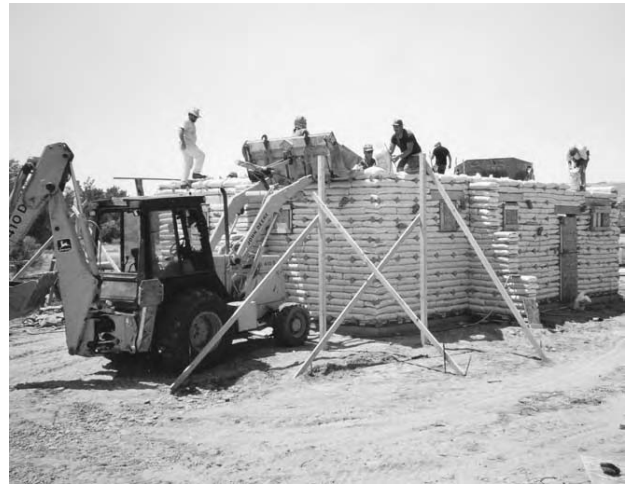
3.35: O echipă formată din 5-7 persoane a construit în 8 zile pereții de 2,86 m pentru Bureau of Land Management Ranger Station (Canton al biroului de administrarea a terenului), de 69 metri pătrați.
