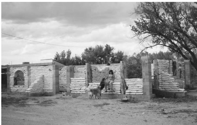
5.17: Casa din saci cu pământ a lui Alison Kennedy, aprobată de codul de construcție, cu stâlpi și grinzi din blocuri de beton.
