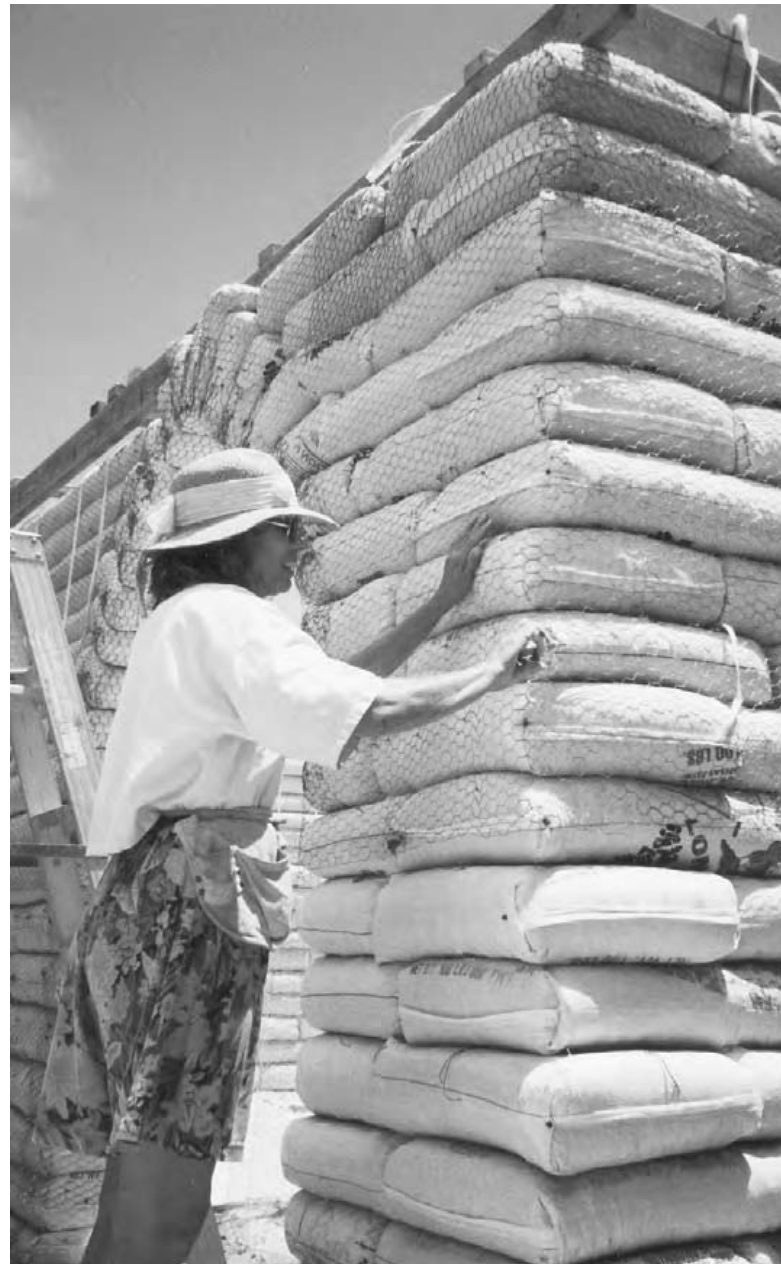
14.20: Carol Escott fixează plasa de sârmă folosind o combinație de fire de sârmă și cuie. Sursa fotografiei: Sustainable Systems Support.
