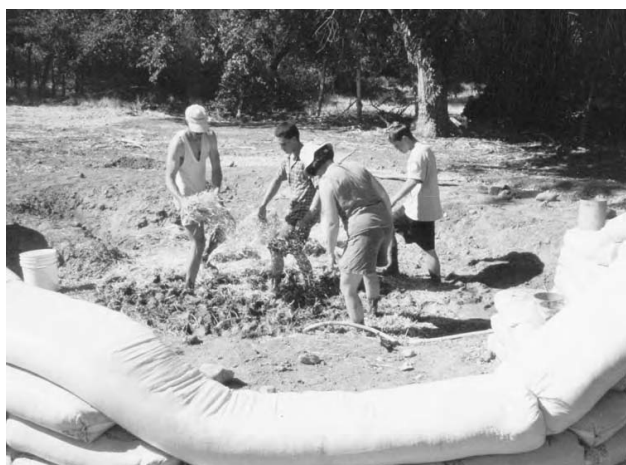
14.6: Preînmuiați pământul într-o groapă și adăugați paie în timp ce bătătoriți noroiul cu picioarele.
