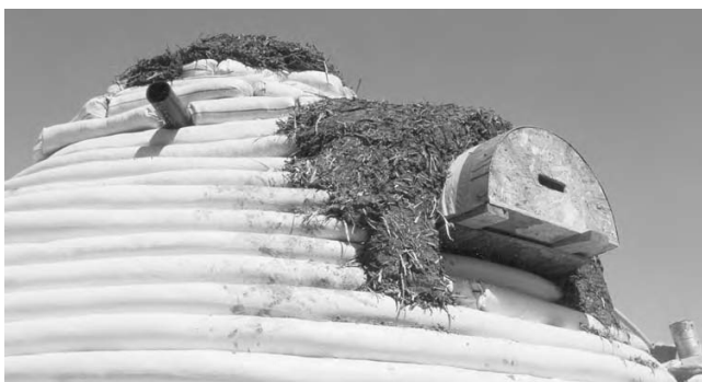
14.11: Sculptarea suportilor de la al doilea etaj în jurul formelor arcuite ale cupolei Honey House.
