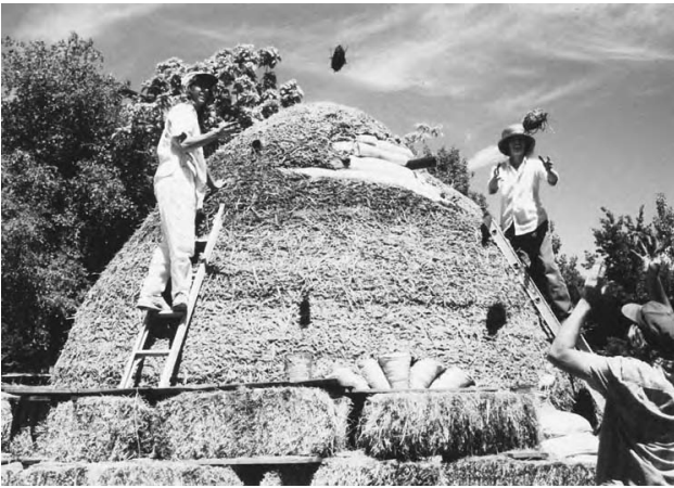
13.2: În cazul tencuielii pe bază de lut rezistente la apă, mărim procentajul de argilă din solul nisipos, îl umplem cu paie lungi, îi dăm forma unei franzele solide și îl aplicăm pe cupolă.
