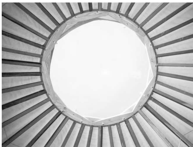
9.21: Privind de jos, din interior, la inelul de compresiune pentru un acoperiș de iurtă.
