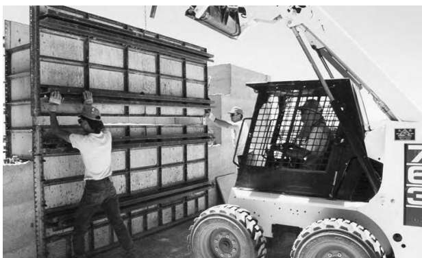
1.5: Cutia cu matrițe poate fi asamblată cu mini-excavatorul. Rafturile de oțel mențin matrițele întocmai și opun rezistență presiunii de tasare.
