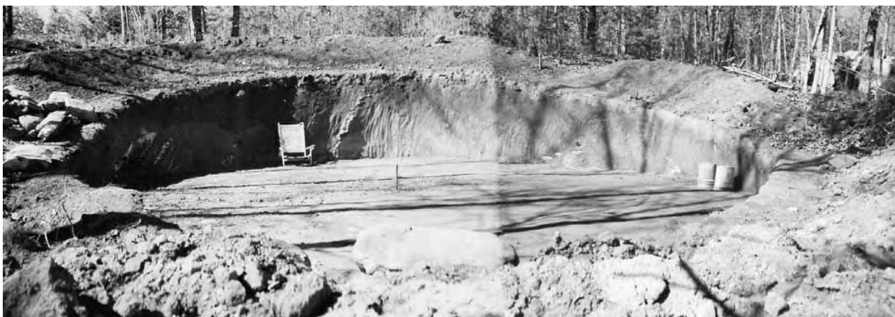
2.5: Deși s-a muncit intensiv, această locație atent excavată nu a deranjat foarte mult vegetația înconjurătoare, punând, totuși, la dispoziția proprietarei pământul necesar construcției.
