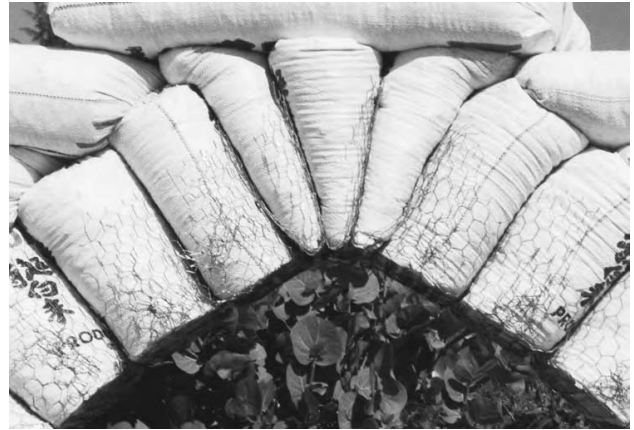
3.23: Este mai bine să ai un spațiu mai îngust pentru cheile de boltă, pentru a încăpea mult mai bine, decât unul prea larg.
