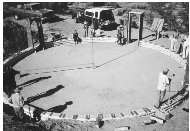
3.41: O casă de tip kiva, cu diametrul de 10,97 m, construită din saci cu pământ în Wikieup, Arizona.
