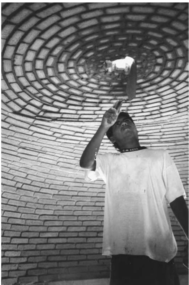
11.8 (jos): Clădirile Boveda sunt construite la un profil aparent imposibil de aplatizat, cu cărămizi de multe ori lăsate expuse în interior. Bovedero: Ramon Castillo. Sursa: Mara Cranic.
