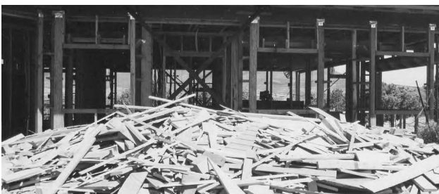
2.33: O sursă excelentă de resturi de lemn pentru construcție sunt șantierele convenționale.
