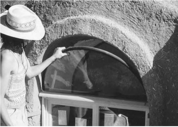
8.7 (dreapta): Tăiați o lungime de 1,56 cm de furtun de cauciuc ca garnitură de etanșare deasupra unei plăci groase de 0,65 cm de geam sau de geam termopan, care a fost tăiat dinainte în formă de semicerc.
