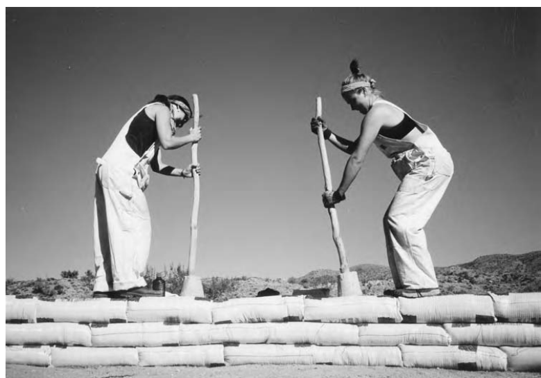
3.12: Rândul este bătătorit de deasupra până când pământul trece de la a face un sunet înăbușit, la un sunet răsunător distinctiv.
