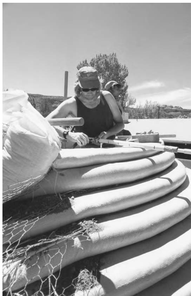
11.21: Cu cât mai mulți saci (tuburi) se vor așeza în consolă peste sacii de bază, cu atât mai mult se vor aplatiza. Sursa foto: Keith G.
