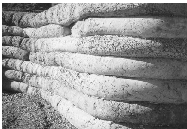
4.7: Din cauza lipsei rezistenței la întindere (în lipsa armăturii metalice), un tub continuu e posibil să crape în ținuturile cu climă rece și umedă, așa că folosirea acestora se recomandă în zonele uscate sau fără îngheț.
