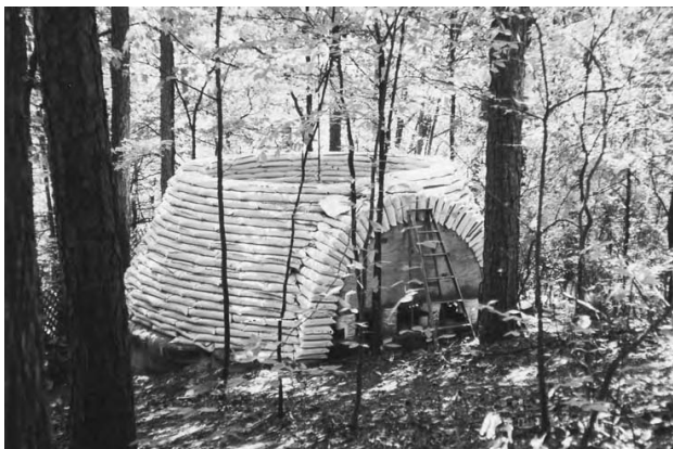
1.2: Cupola din saci de pământ în construcție a Marlenei Wulf, în sânul pădurilor din Georgia.
