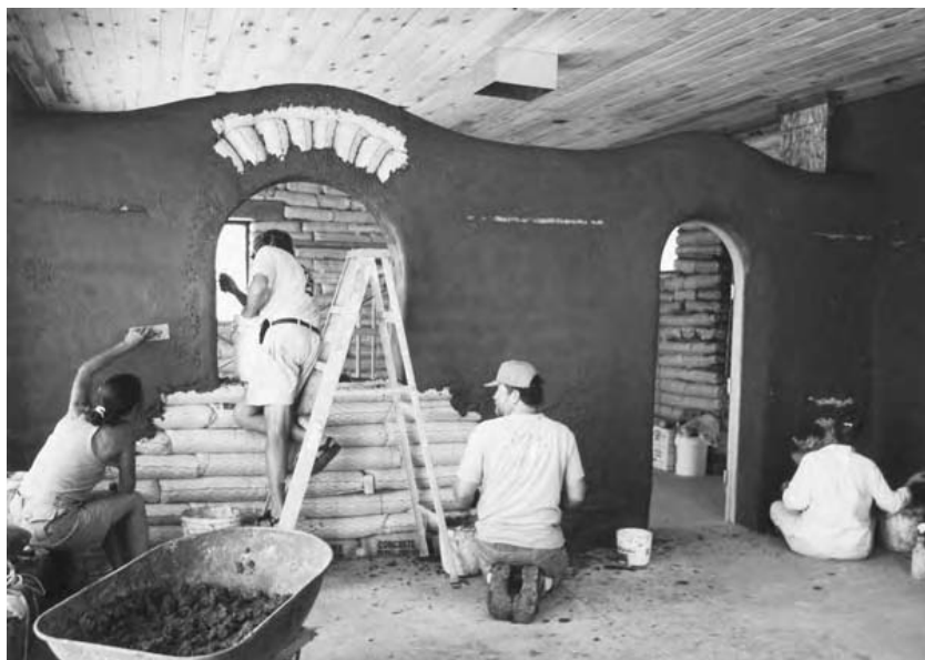
15.2 (stânga): Am fost încântați de oportunitatea execuției unei tencuieli pentru un perete creat în totalitate din pământ natural, într-o clădire guvernamentală deschisă publicului.
