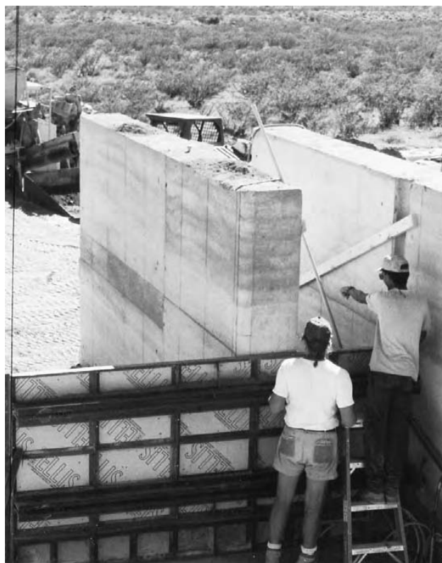
1.6: Zid de pământ compresat după îndepărtarea matrițelor.
