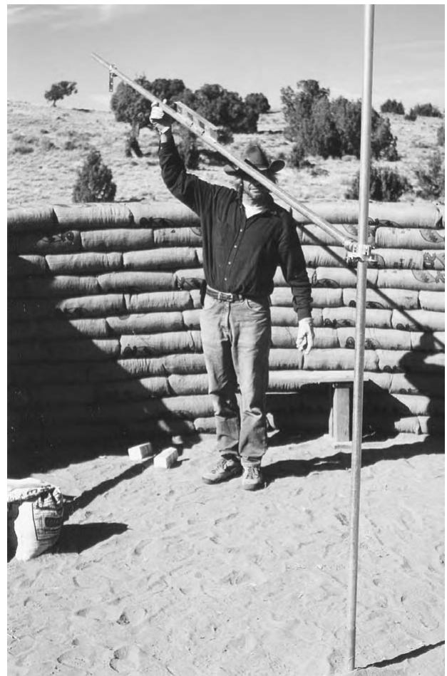
3.40: Un compas prăjină cu braț articulat. Observați nivelul atașat.
