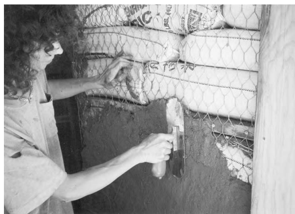
15.5: Tencuiala fără fibră se aplică repede și umple bine toate golurile dintre rândurile de saci, până când se așază la același nivel cu plasa de sârmă.
