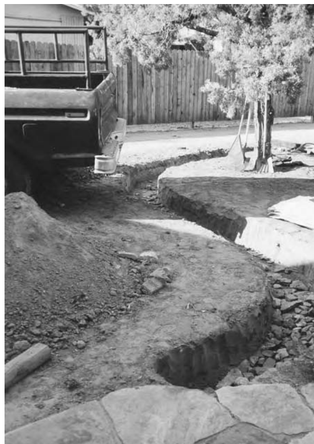
4.5a, 4.5b: Vedere a unui șanț simplu (A) cu piatră spartă cu talpă din piatră brută, (B) acoperit cu pietriș curat și bine tasat.
