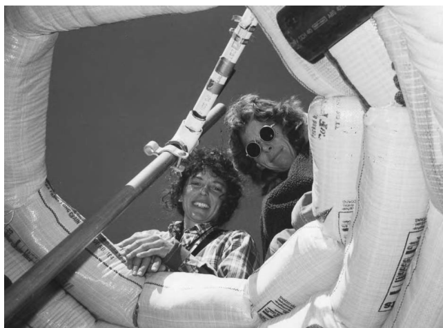
12.30: Observați cât de mult depășește rândul de saci de sus, rândul precedent.
