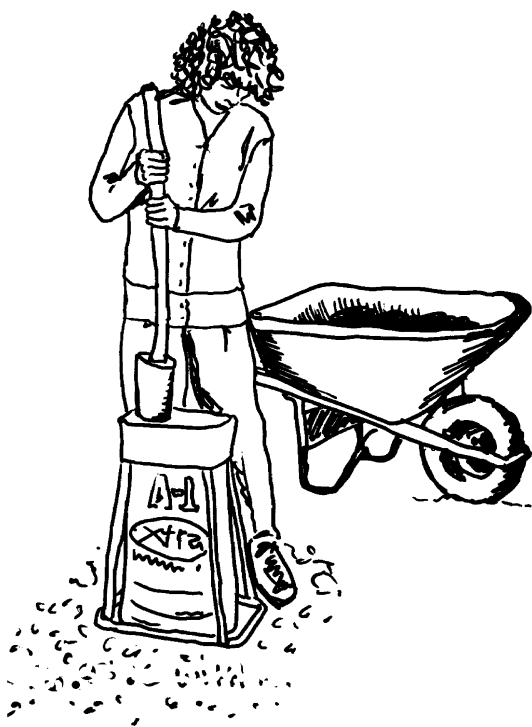
6.7: Compactare cu ajutorul unui sfert de mai.
