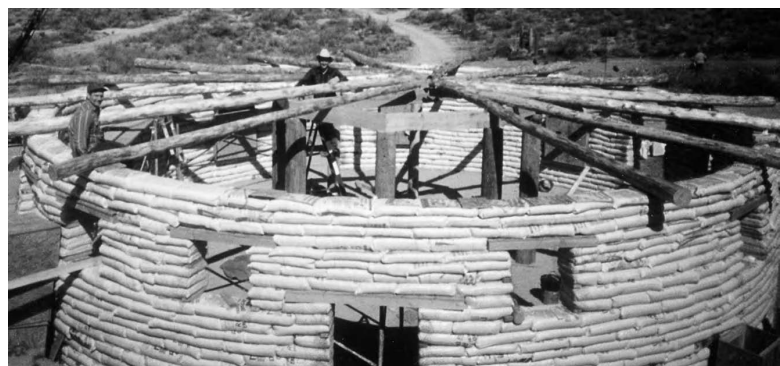
9.18: Un excelent exemplu de clădire tip kiva din saci cu pământ este casa lui Penny Pennel (de 10,8 m diametru), care utilizează sistemul hexagonal de grinzi și stâlpi interiori care sprijină grinzile, lungi de 6 m. (Sursa: Penny Pennell)
