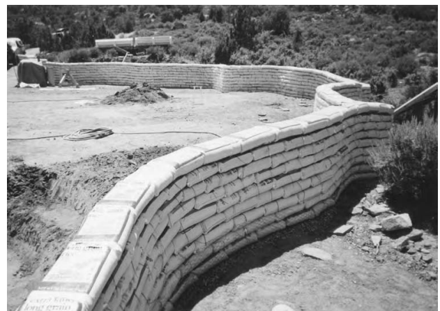
5.4: Pereții suficient de curbați se susțin independent din părțile laterale.
