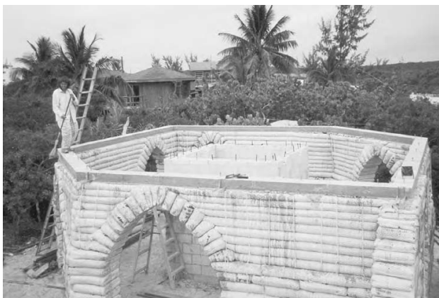
9.2: Grinda de legătură trebuie să fie continuă, acoperind întregul perimetru al peretelui.
