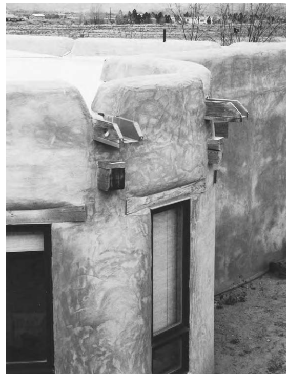
9.14: Acoperiș plat cu parapeti și scurgeri.
