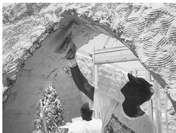
14.18: Aplicarea stucului din var pe bază de ciment peste plasa de rabiț de pe Sand Castle, în Rum Cay, Bahamas. Fotografie realizată de Steve Kemble și Carol Escott
