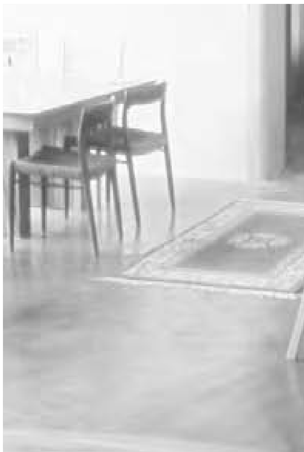
16.1: Patina frumos finisată a acestei podele de pământ îmbunătățește casa din baloți de paie a lui Kalen Jones și Susie Harrington din Moab, Utah.
