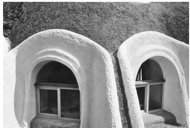
13.3: Fețele verticale ale Honey House sunt protejate cu tencuială de var, în timp ce pervazurile sunt făcute din pământ stabilizat cu var. Ambele au rezistat foarte bine timp de cinci ani.
