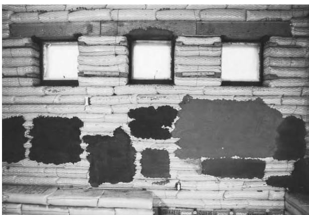
15.4: Porțiuni de tencuială pentru testare la Cantonul forestier din Sand Island.
