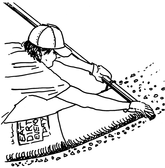
12.7: Folosiți brațul compasului pentru a contura forma fiecărui sac, pentru a fi conform cu cercul.
