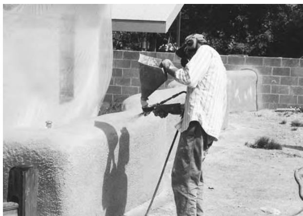
14.16c: Aplicare cu pulverizatorul.
