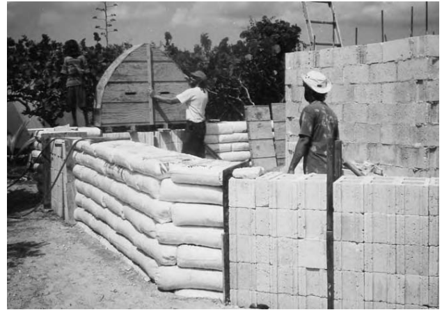
2.27: Blocurile din zgură sunt foarte bune ca și cofraje.
