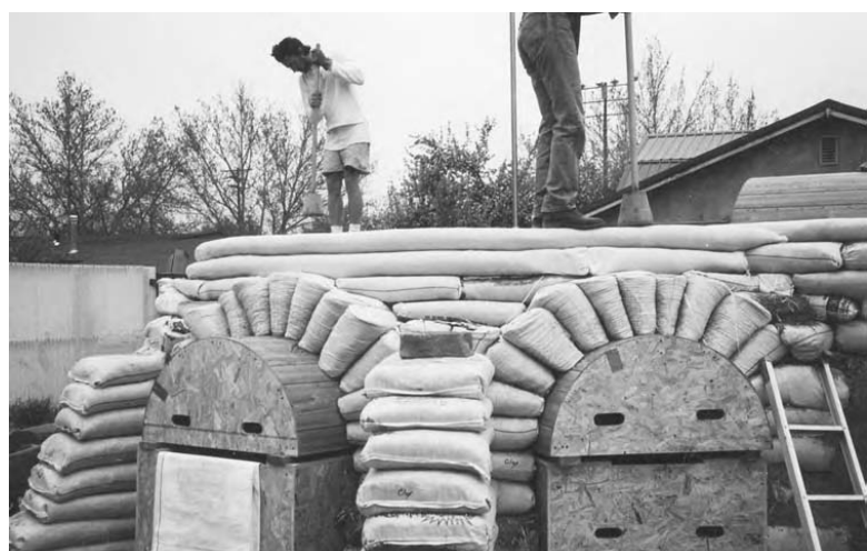
12.22: După compactare, fiecare rând ar trebui să se simtă la fel de tare ca un trotuar.
