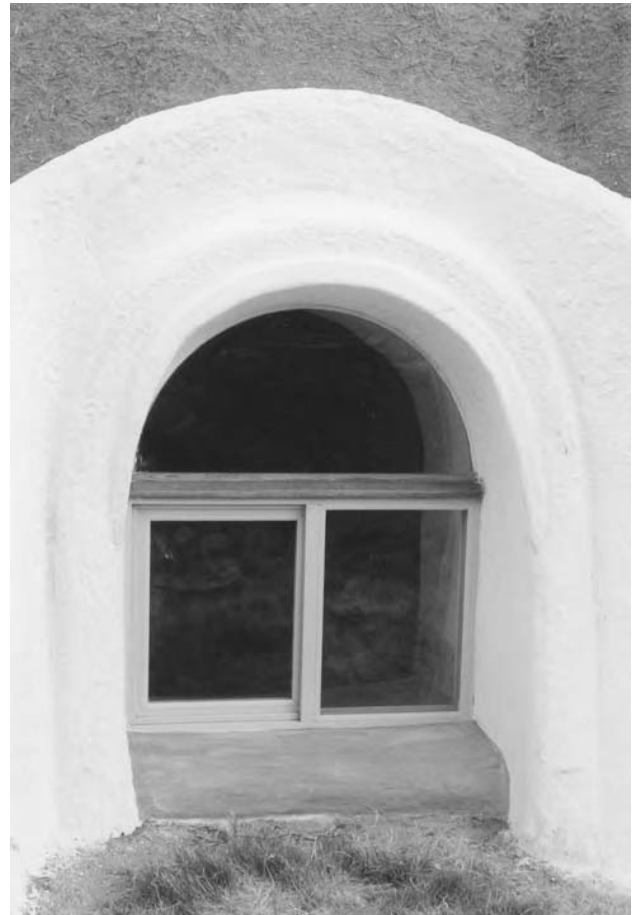
8.4: Frumusețea unei ferestre arcuite este dată de faptul că forma este atât atractivă, cât și structurală. Alegem arcul roman (semicerc) pentru majoritatea caselor, deoarece este cea mai simplă formă în care se pot crea ferestre funcționale.
