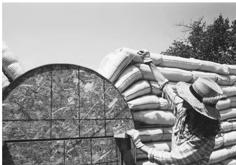
10.8: Sfoara atașată servește ca ajutor vizual în determinarea unghiului potrivit pentru modelarea sacilor evantai.
