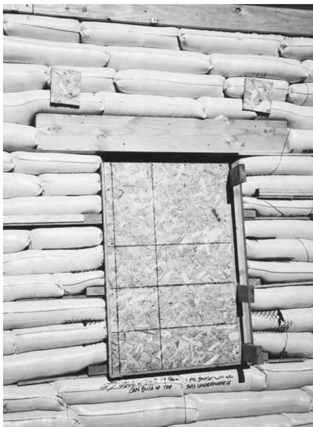
8.2: Un exemplu de buiandrug pre-atașat de plăci de prindere, care se prelungesc cu încă 20 cm dincolo de capetele buiandrugului.
