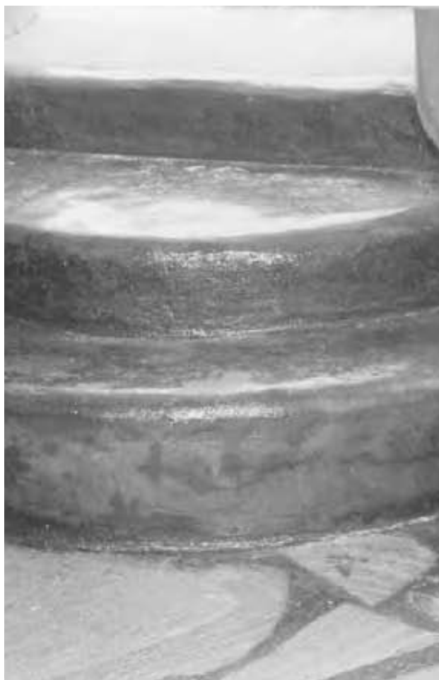
16.8: Pavajul de plăci și faianță antică de Malibu, rostuit cu pământ, înfrumusețează podeaua domului Honey House.
