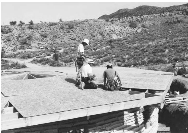
9.19: Penny a utilizat un cadru din cherestea instalat deasupra grinzilor, acoperit cu placaj deasupra și izolat dedesubt.
