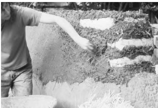
14.7d (jos): Găurirea tencuielii cu degetele pentru aderență.
